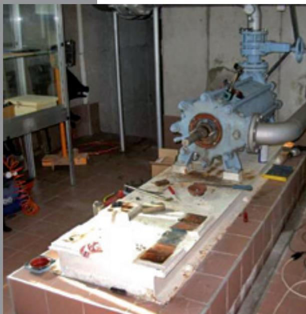
Vétusté, usure des pompes de refoulement constatées lors de la révision partielle.
