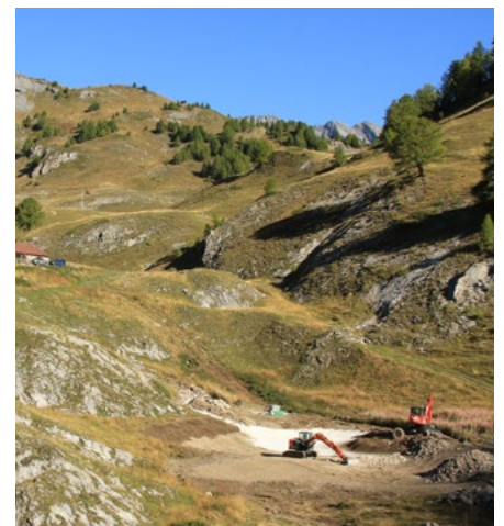
Cet été, les machines se sont activées pour creuser les étangs. Ceux-ci seront alimentés par un ruisseau existant qui les reliera entre eux.
