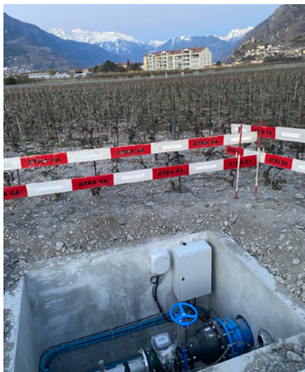
Si le chantier peut paraître anodin, le réseau étant invisible, ce ne sont pas moins de 22 hectares qui sont désormais équipés d'un réseau principal d'irrigation, et donc de lutte contre le gel. Ici, une tête de puits installée dans une chambre en béton.
