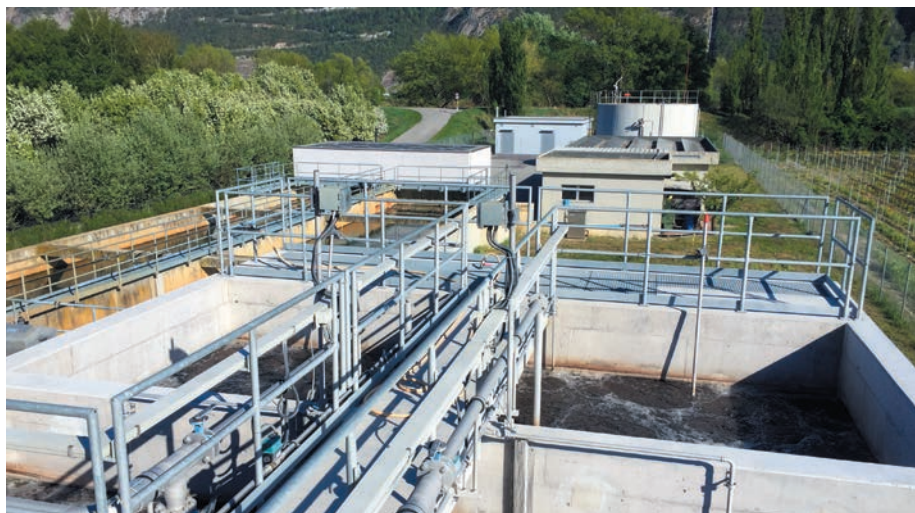
Quatre nouvelles cellules dédiées à la dégradation du carbone ont été ajoutées.
