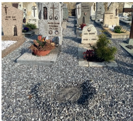
Au cimetière a été posé un géotextile recouvert de 5 cm de gravier. Résultat: plus d'herbes indésirables dans les allées, pour une intervention considérablement réduite et sans herbicides.
